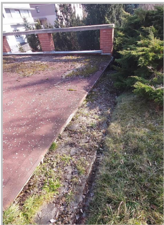
Obrázek č. 8 a 9 : Odvodnění plochy střechy / okapový chodník
