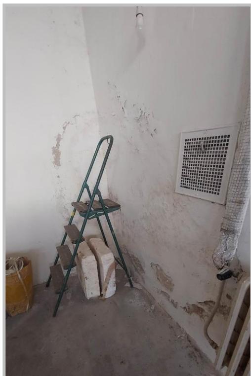
Obrázek č. 6 a 7: Pohled na stěnu garáže s vlhkostními projevy / prostor zázemí
